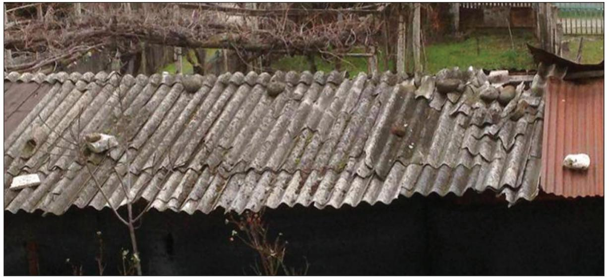
*Esempi di degrado e di incuria di lastra in cemento amianto*
